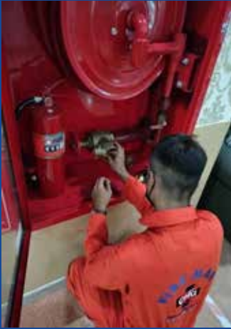
การทดสอบลากสายฉีดน้ำดับเพลิงและทดสอบการเปิดน้ำ
