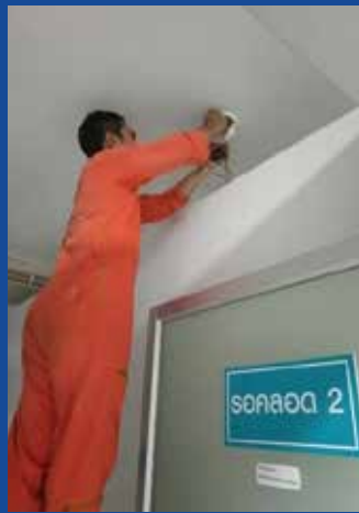
การทดสอบระบบ Fire Alarm (Smoke Detector, Heat Detector และ Manual Station)
