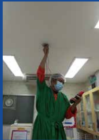
การทดสอบระบบ Fire Alarm (Smoke Detector, Heat Detector และ Manual Station)
