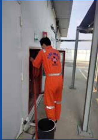
การทดสอบลากสายฉีดน้ำดับเพลิงและทดสอบการเปิดน้ำ
