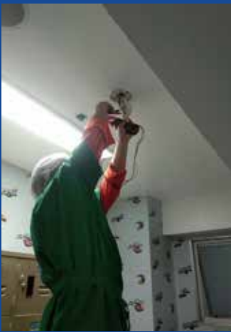
การทดสอบระบบ Fire Alarm (Smoke Detector, Heat Detector และ Manual Station)
