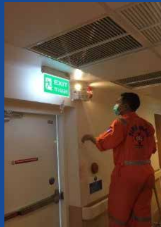
การทดสอบระบบ Fire Alarm (Smoke Detector, Heat Detector และ Manual Station)
