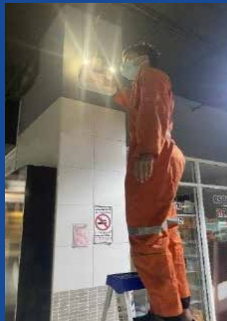
การทดสอบ ไฟฉุกเฉิน และ ป้ายกล่องหนีไฟ
